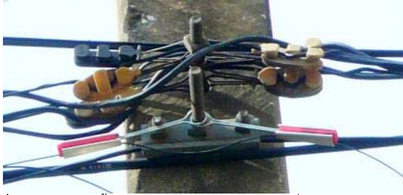
ภาพประกอบที่ 14. ทดลองติดตั้งอุปกรณ์ Dropwire Clamp แบบลิ่มล๊อคกับสาย OFC Round Type
