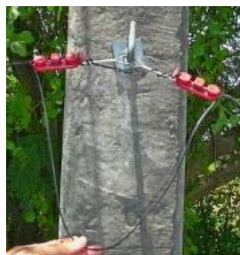
ภาพประกอบที่ 5. สายสะพานฯ ลวดเหล็กสปริงแข็งต้องพันกับแกนโลหะของ Dropwire Clamp
