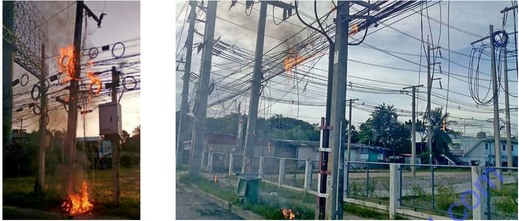
ภาพประกอบที่ 6. ปัญหาไฟไหม้ขั้วสายเคเบิลสื่อสารตามแนวเสาไฟฟ้า
